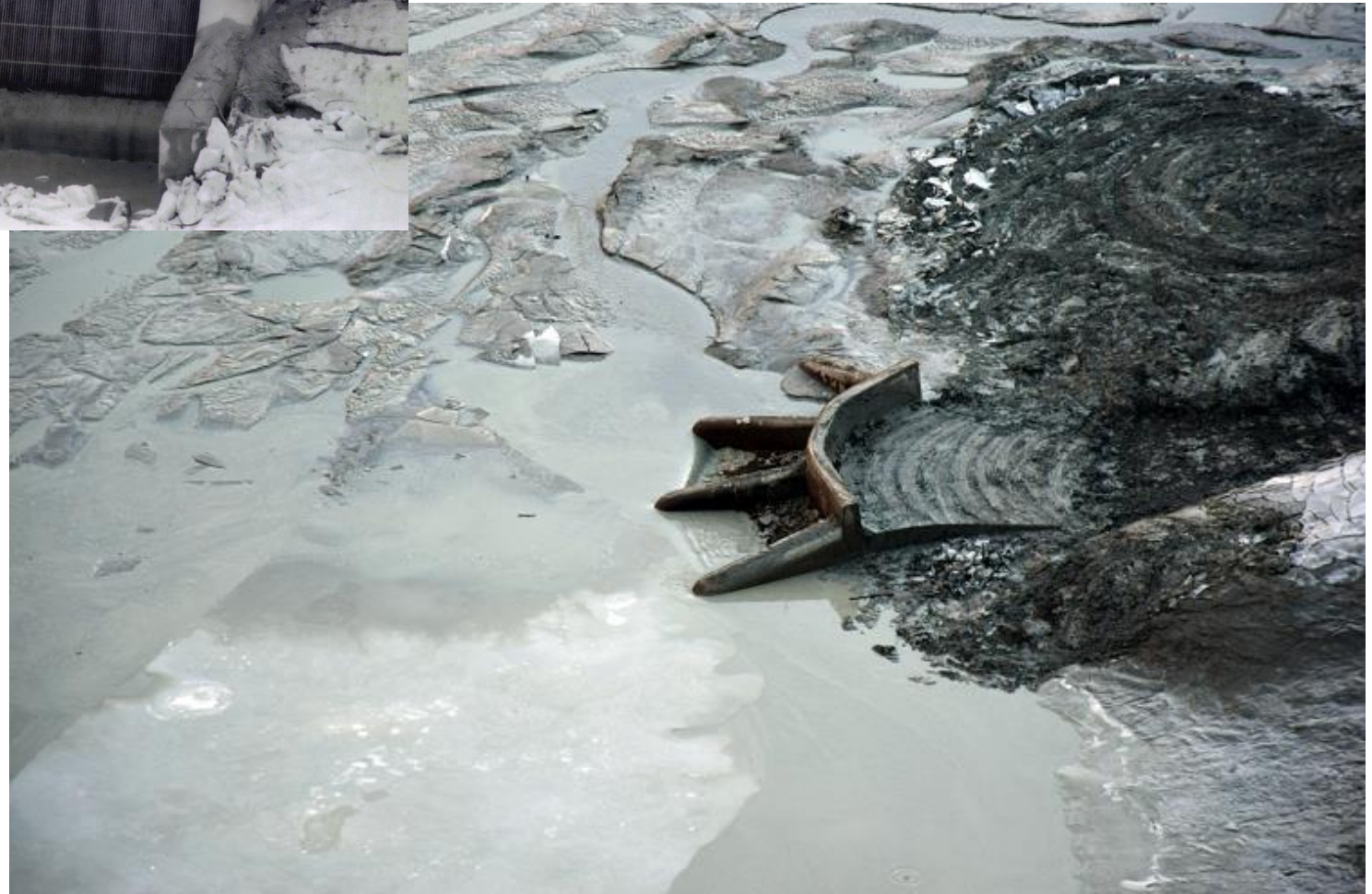
TW-Einlauf Speicher Gepatsch am 24.12.2015
