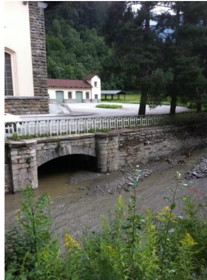
Verlandetes Rückgabebauwerk Pfitsch
