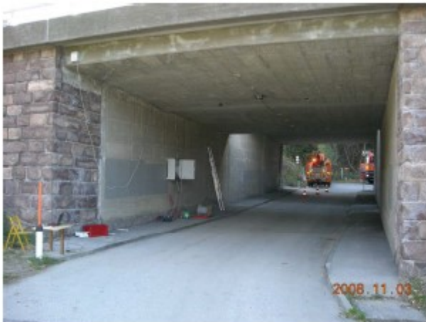
B88 Feldwegunterführung BWIM-Messung 2008
