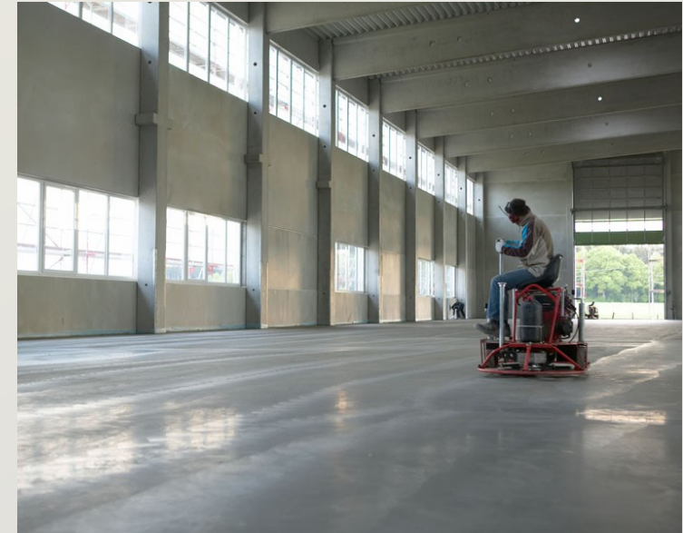
Einarbeiten der Hartkorneinstreuung durch maschinelles Glätten (Flügelglätter)
