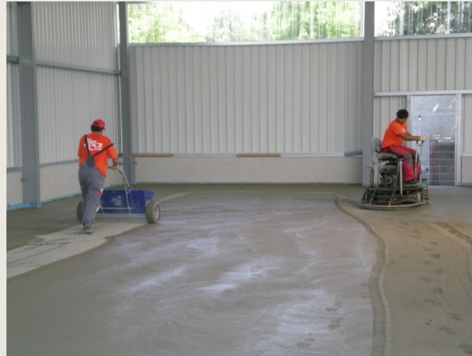
richtiger Zeitpunkt zum Aufbringen der Hartkorneinstreuung; gleichmäßige Verteilung des Einstreumaterials (Einstreuwagen) (3 – 5 kg/m 2 )
