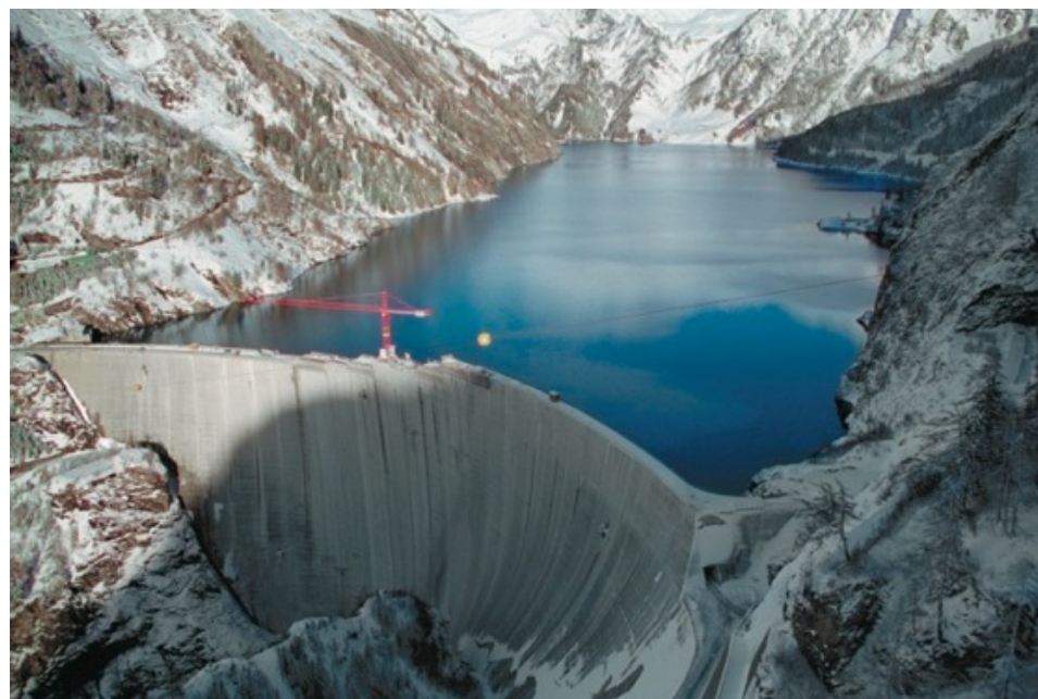
Erhöhung der Luzzone Bogenmauer in der Schweiz
