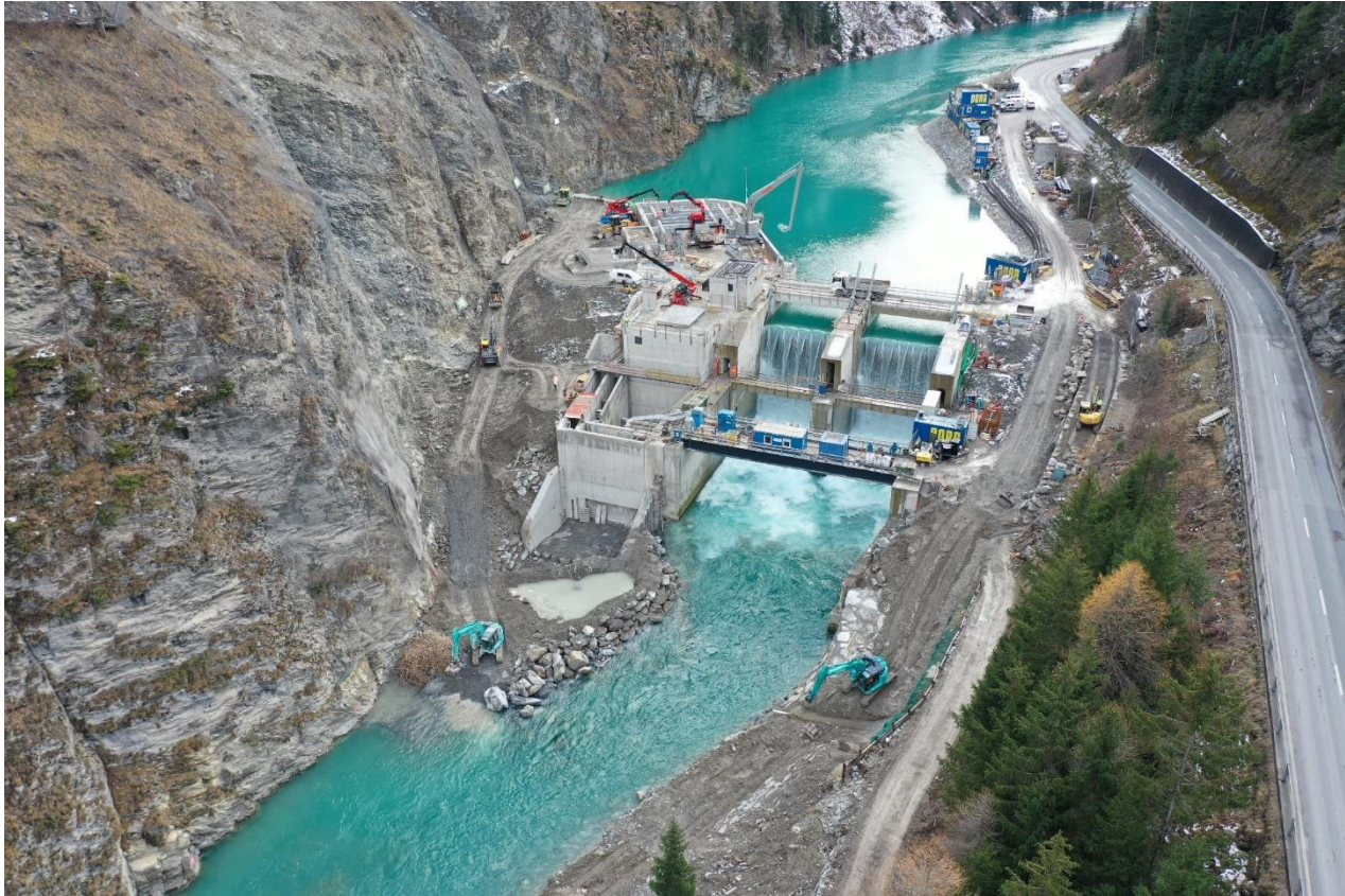
Drohnenaufnahme des Wehrs bei Teilstau am 30.11.2022
