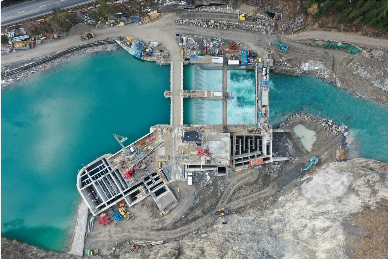
Drohnenaufnahme des Wehrs bei Teilstau am 30.11.2022
