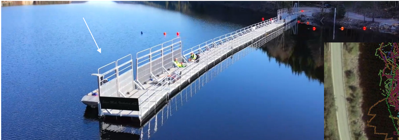
Pilotanlage eines MBR-Fischleitrechens für Lachse am Kraftwerk Laudal
