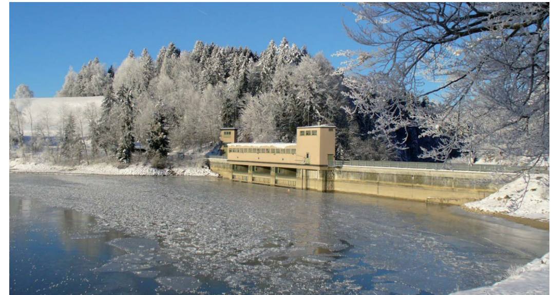
Gewichtsstaumauer "In den Schlagen" (Foto: M. Fuchs)
