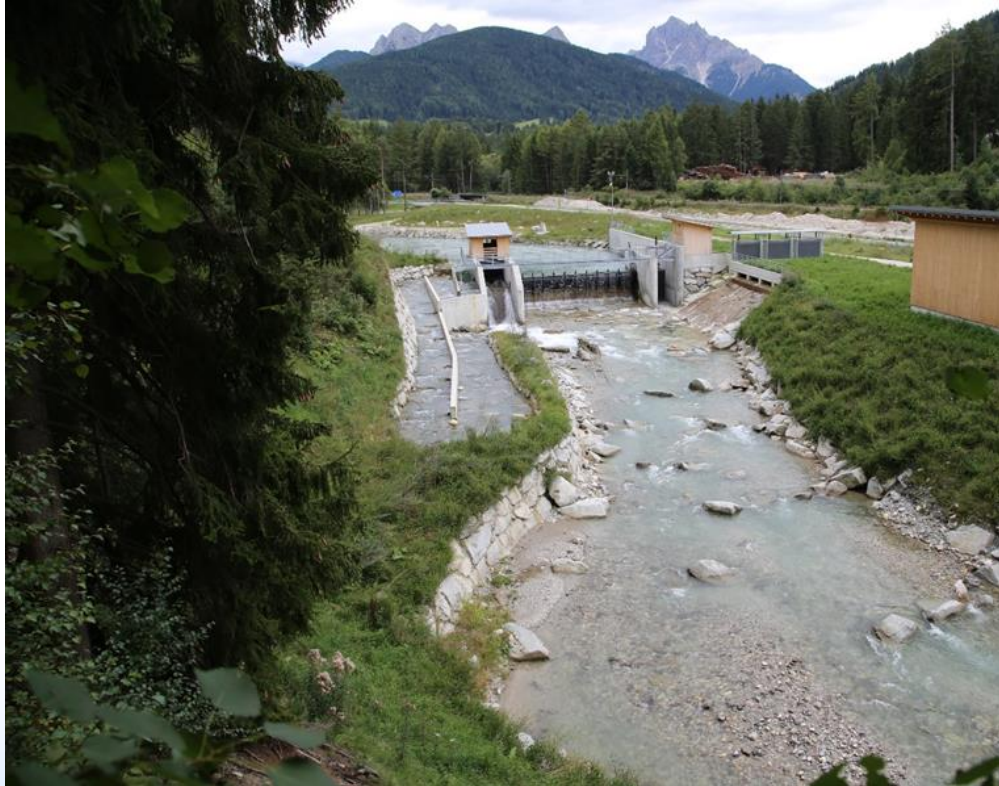
Restwasserdotation über Archimedes-Schnecke und FWH als raue Rampe an der Rienz
